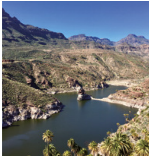
Reservoir la Sorrueda.
