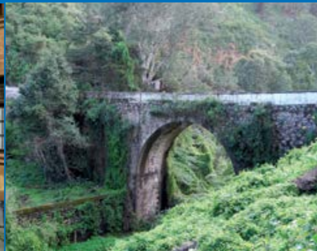
Puente del Molino
